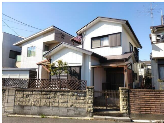
建物取り壊し更地渡し
