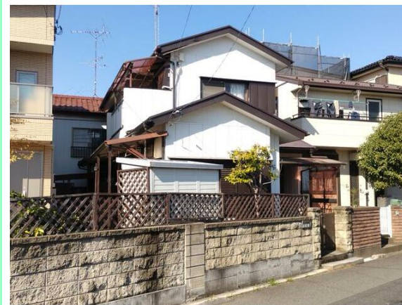
建物取り壊し更地渡し
